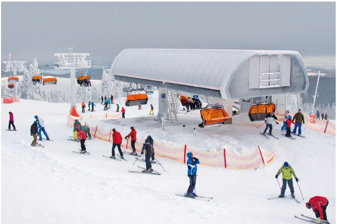
Рисунок 2 — Верхняя станция канатной дороги (VSKD)
