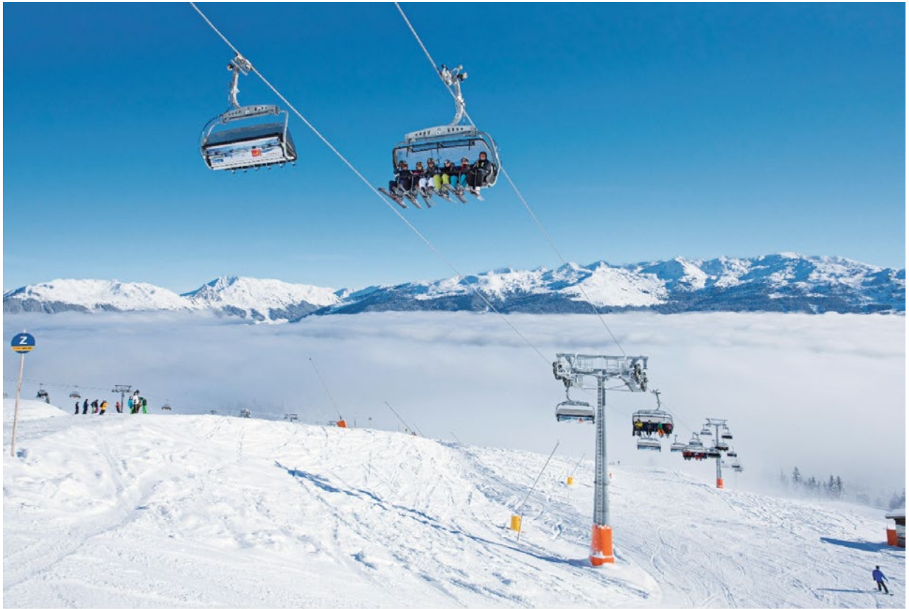
Рисунок 1 — Промежуточные опоры канатной дороги
