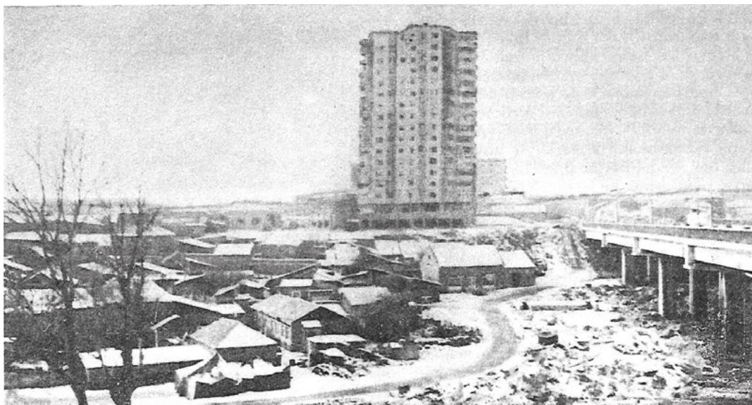
Рисунок 4 — 16-этажный дом в Ленинанконе, возведенный методом подъема перекрытий. Горизонтальные отклонения верхнего перекрытия после землетрясения – 120 см. Впоследствии дом взорван.
