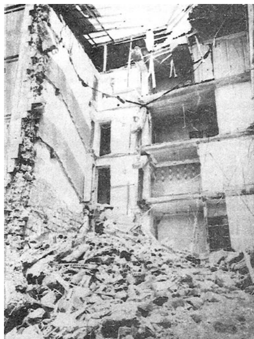
Рисунок 6 — 4-этажный дом с комплексными стенами
