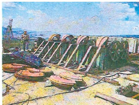
**Рисунок 13** — Вибромашина ЦНИИЭП жилища, установленная на крыше одного из домов в Нерюнгри, моделирует горизонтальную сейсмическую нагрузку на здание
