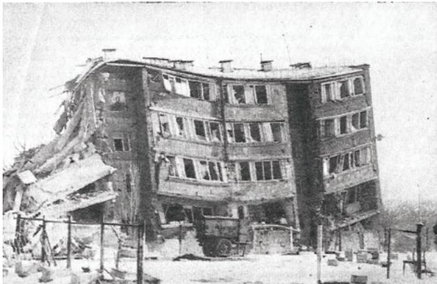
**Рисунок 1** — Повреждение одного из зданий Ленинакана, где строители допустили серьезный брак, уложив в ряде случаев между блоками вулканического камня – туфа вместо раствора строительный мусор
