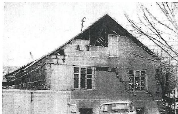
Рисунок 3 — Полуразрушенный дом из туфа в Спитаке
