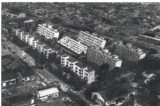
**Рисунок 4** — Дома упали или сильно накренились вследствие разжижения грунта
