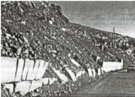
**Рисунок 15** — Обвалы железобетонных подпорных стен около Спитака [1]
