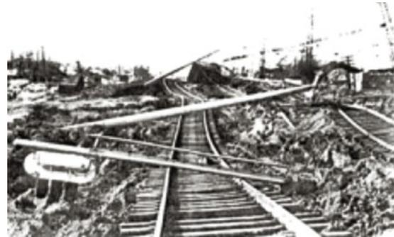
**Рисунок 17** — Повреждения железной дороги около станции Налбанд [4]
