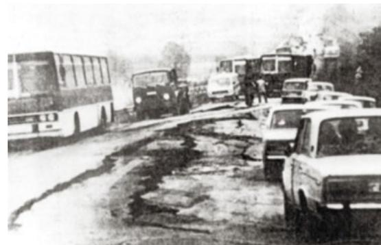
**Рисунок 18** — Трещины, образованные в проезжей части дорог [4]
